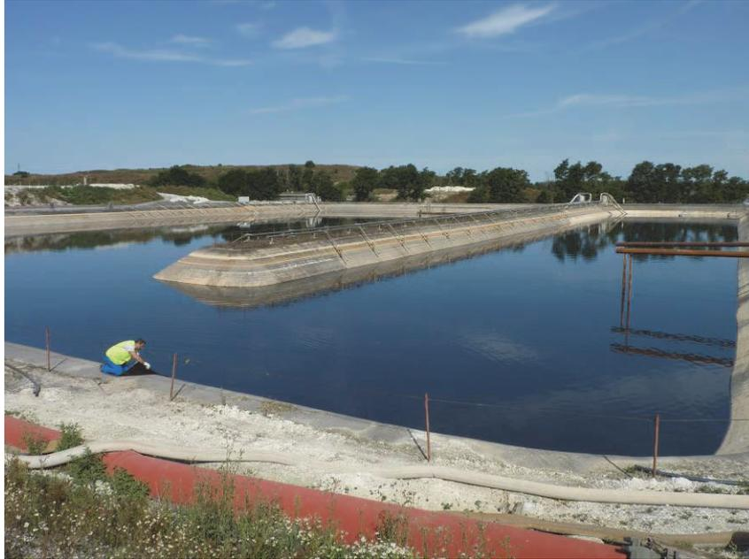
Figure 1. Vue du bassin 5 du site de Bazancourt au moment du prélèvement des géomembranes
